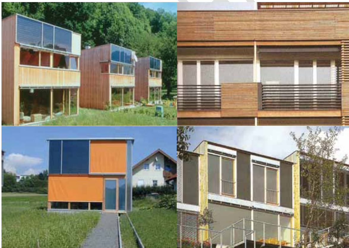
Слика 6 Сончеви системи за греење и ПТВ интегрирани во елементи на фасада и огради на тераси
