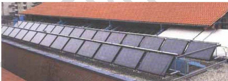
Слика 8 Сончев систем од група на колектори монтирани ка кровни носачи
