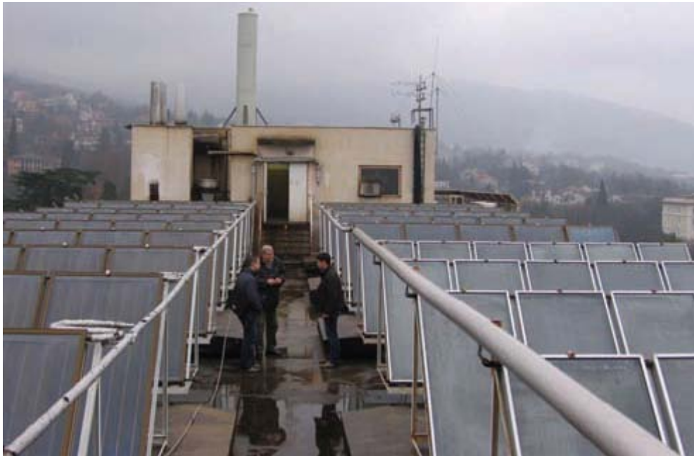
Слика 10 Сончеви колектори вградени на рамен кров од градба
